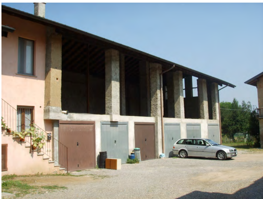
Porticato al 1° piano (fienile)
