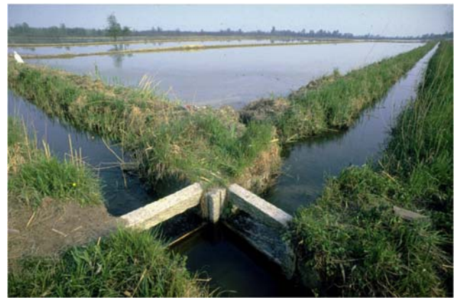
sistemi di smistamento delle acque irrigue
