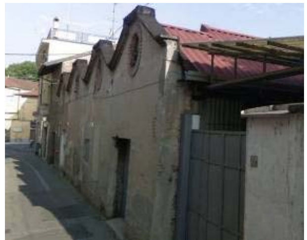
Edificio produttivo in via Piave
