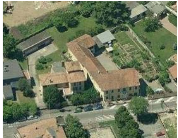
Edificio in via Garibaldi
